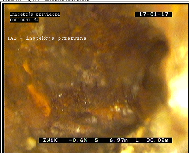
6.97 m - IAB - inspekcja przerwana
