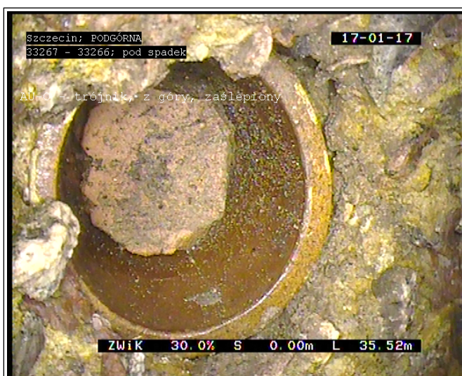
35.52 m - AU-O - trójnik, z góry, zaślepiiony
