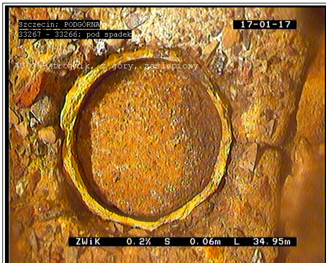
0.06 m - AU-O - trójnik, z góry, zaślepiiony
