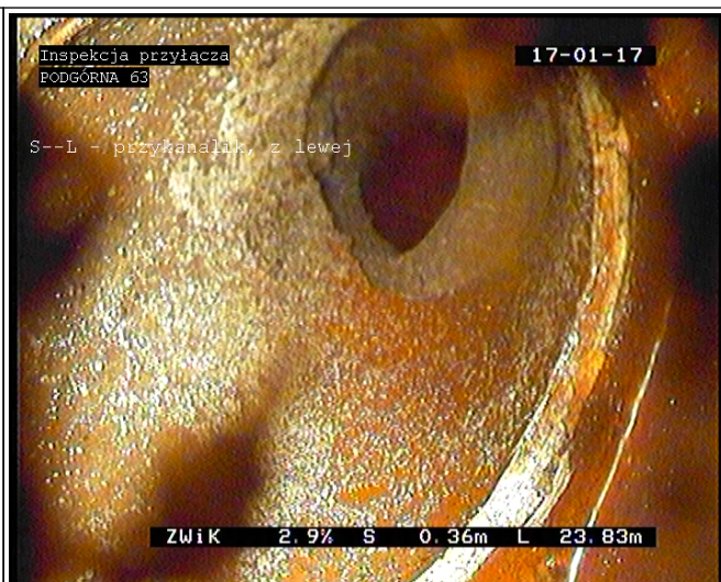
0.36 m - S--L - przykanalik, z lewej
