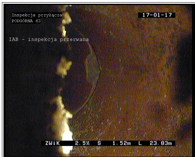
1.52 m - IAB - inspekcja przerwana
