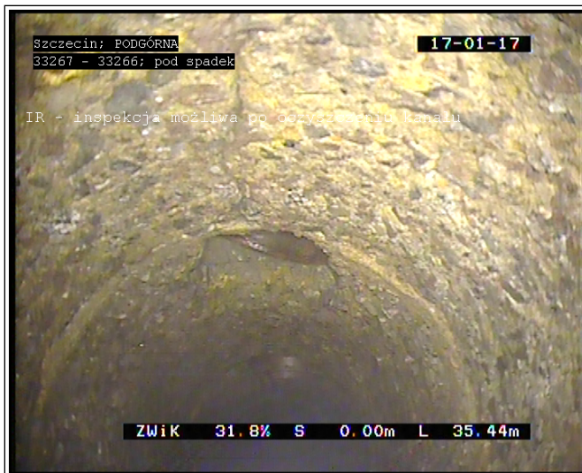
35.44 m - IR - inspekcja możliwa po oczyszczeniu kanału
