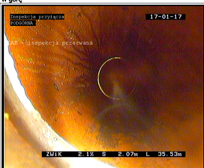
2.07 m - IAB - inspekcja przerwana
