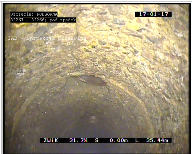
35.44 m - IAB - inspekcja przerwana
