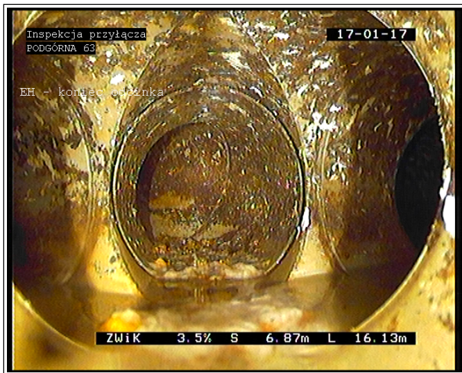
6.87 m - EH - koniec odcinka
