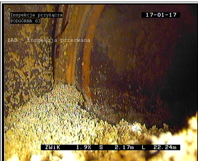
2.17 m - IAB - inspekcja przerwana
