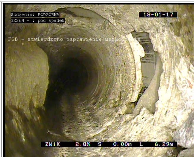
6.29 m - FSB - stwierdzono naprawienie uszkodzenia
