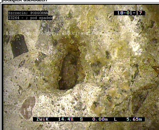
5.65 m - BSBO - odprysk rury, widoczna ziemia, z góry
