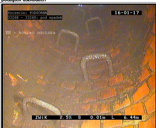
6.44 m - EH - koniec odcinka
