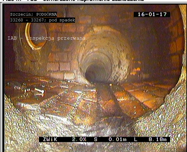
8.18 m - IAB - inspekcja przerwana
