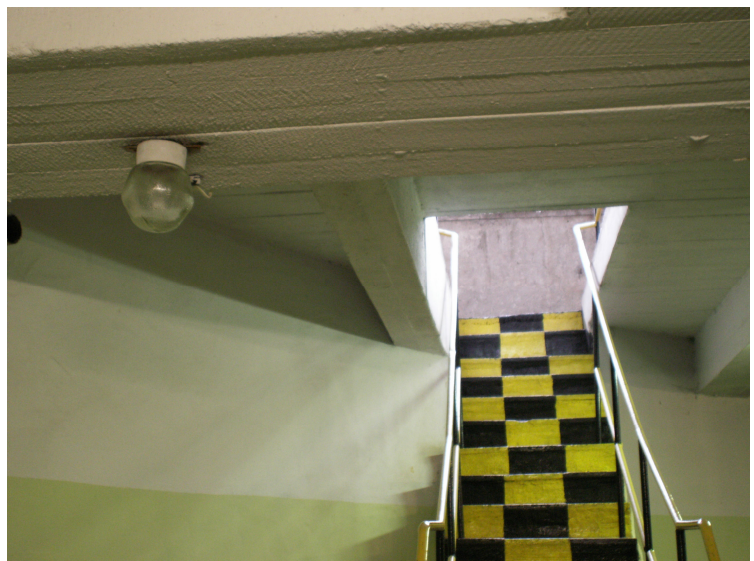
Stan stropu w poziomie parteru
