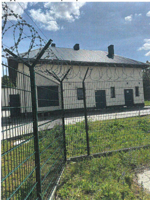
Zdjęcie nr 1. Hala pomp
