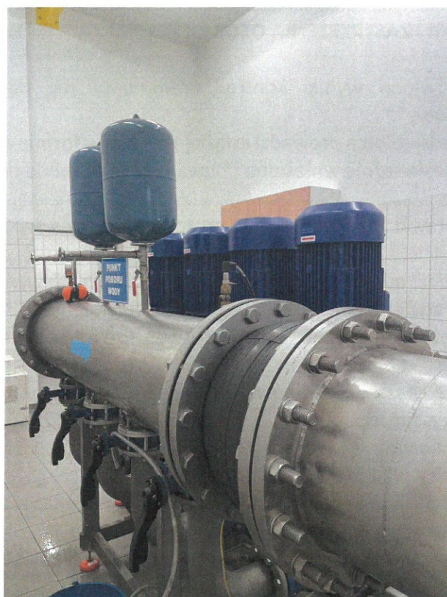
Zdjęcie nr 2. Rurociąg
