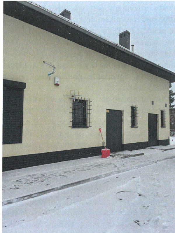
Zdjęcie 4. Budynek pompowni
